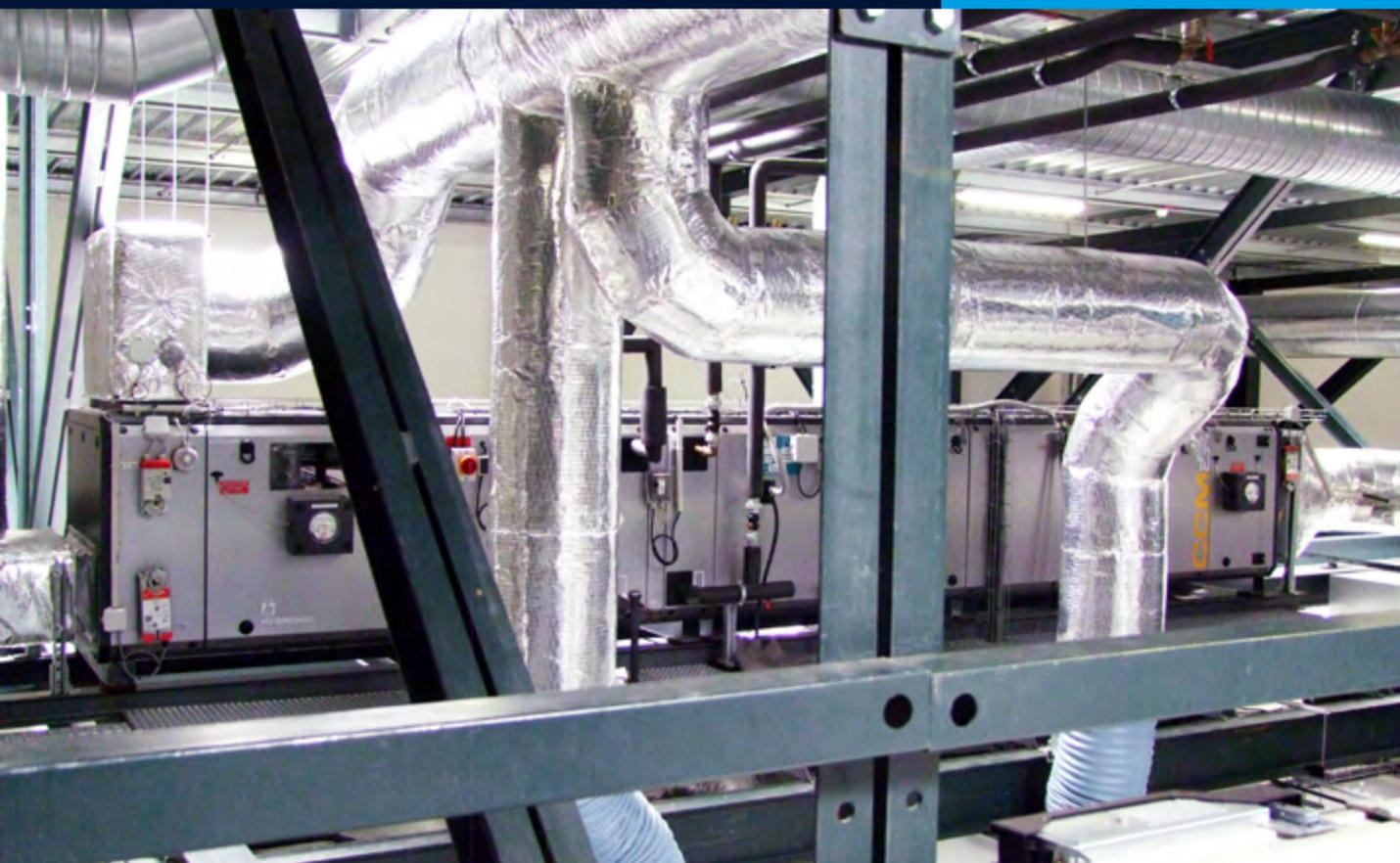
Centrale de régulation de température et d'hydrométrie
